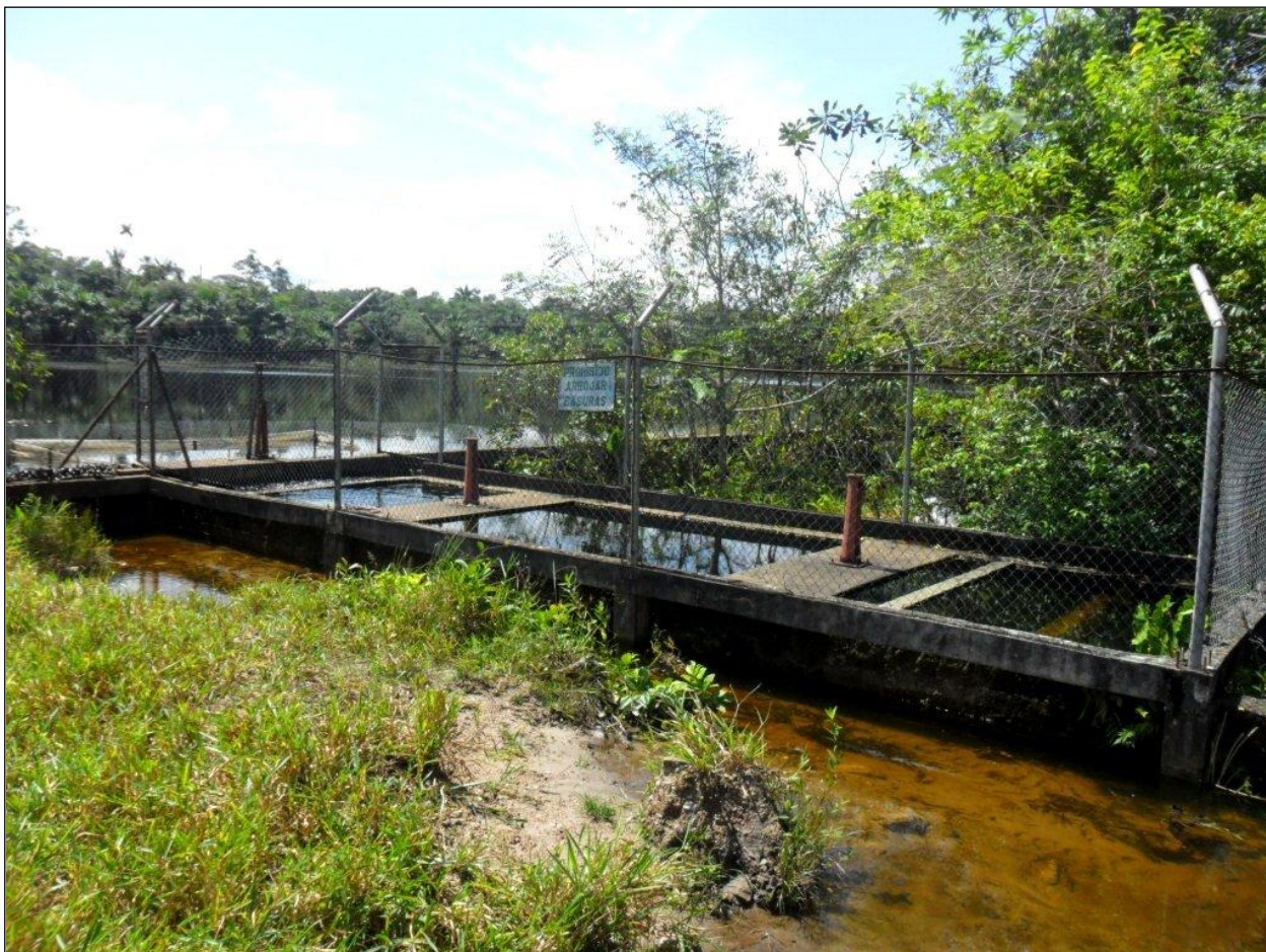
Foto 7. Embalse de aducción del acueducto de EMPOAGUAS ESP
