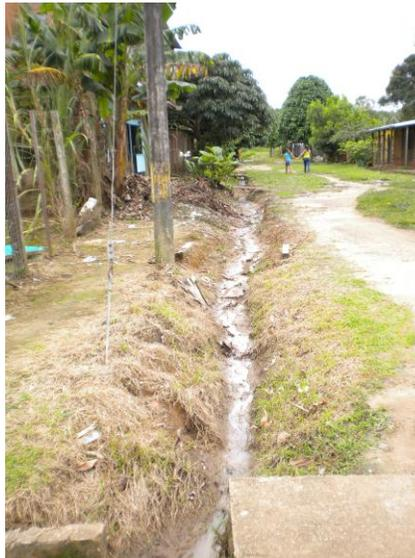
Foto 33. Vertimiento de agua residual sobre el caño
